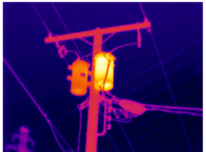
Túlmelegedett oszlop transzformátor
